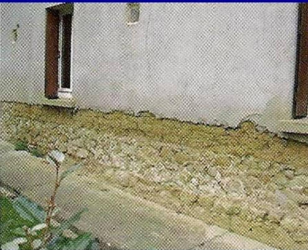
Saignée de sauvetage sur le soubassement d'un mur en adobe (briques de terre crue) avant enlèvement complet de l'enduit ciment, du trottoir en béton et de l'isolant intérieur avec son pare-vapeur.
