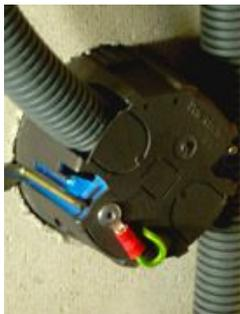
Le raccordement à la terre des structures métalliques de la construction, des carcasses métalliques des appareils et machines électriques est indispensable pour supprimer le rayonnement de champs électriques par ces éléments en métal. C'est le fil vert/jaune qui sert à faire les raccordements à la terre..
