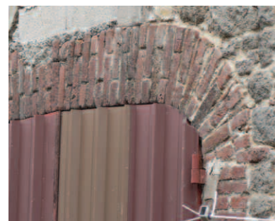
Linteau en briques en anse de panier.
