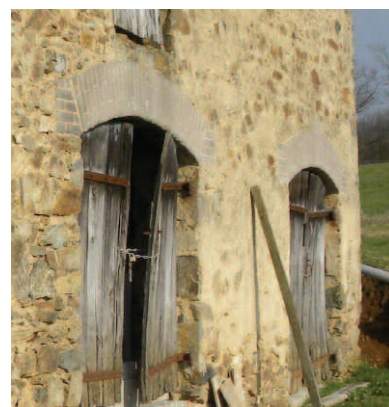
Linteaux cintrés en brique.
