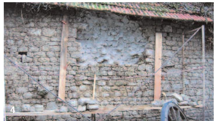
Après arrachage du lierre, le parement extérieur en bon état est sécurisé de part et d'autre de la « plaie » par deux grosses planches, maintenues en place verticalement par des chevillettes (1, 2). Un mortier à la chaux hydraulique d'accrochage est jeté à la truelle, après humidification du fond (3). Le parement extérieur sera remonté lit par lit (4).
