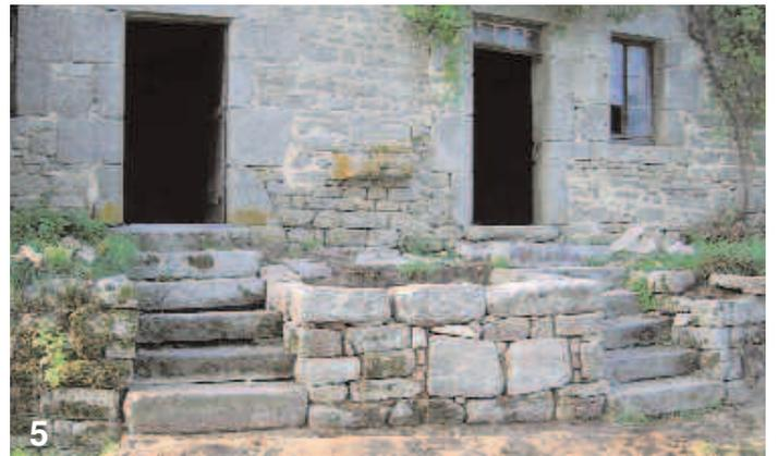
Les escaliers ont besoin d'un remaniement (1). L'assise des marches est consolidée et la partie centrale est démontée (2, 3). Elle sera remplacée par un muret en U (4, 5).
