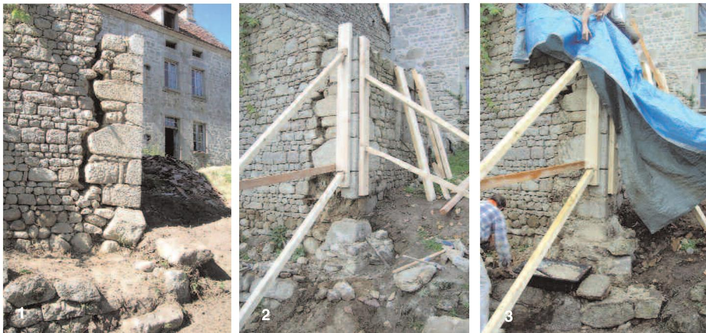
Décrochement impressionnant d'une chaîne d'angle sur un bâtiment annexe qui sera utilisé pour relier les deux logis.
